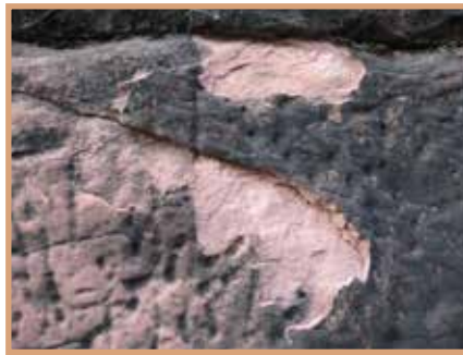
ผิวของหินหลุดออก เป็นกาบ ๆ หรือเป็นแผ่น ๆ
