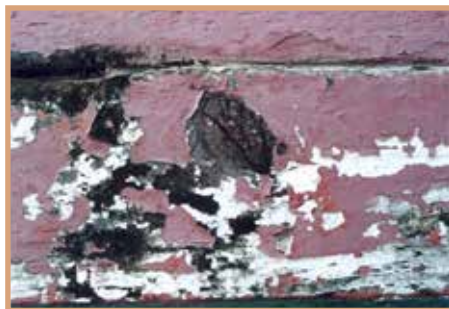
สารเคลือบผิวต รอสต่อแตก และหลุดล่อนจาก ผิวไม้
