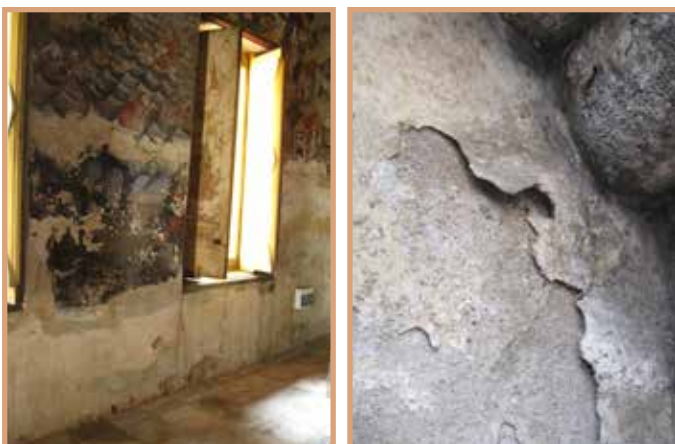
ความชื้นและสารละลายของเกลือที่แทรกซึมขึ้นมาบนผนัง ทำให้ภาพเขียนและปูนชำรุด
