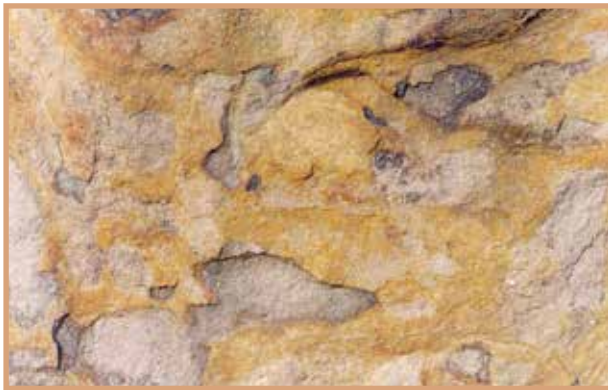
ใบเสมาหินทราย ที่ปักอยู่ในดินเค็ม กำลังเปื่อยยุ่ย
