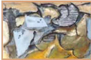
การเสื่อมสภาพของกระจกสี/กระจกเงาบนปูนปั้นและไม้ประดับกระจก
