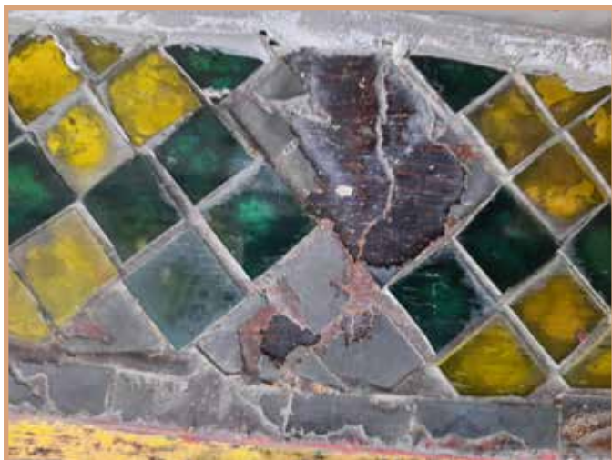
การซ่อมแซมโดยใช้กาวยกที่มีแรงยึดเหนี่ยวสูงเกินไป ทำให้กระจกชำรุดเร็วขึ้น
