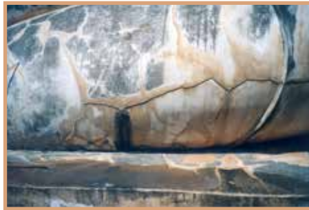
การซ่อมแซมรอยร้าวบนปูนปั้นโดยใช้วัสดุที่ไม่เหมาะสม
