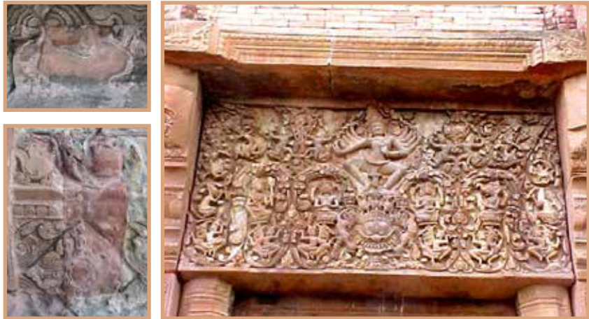
การเสื่อมสภาพของ หินทรายสีชมพู-แดงที่อยู่ กลางแจ้ง
