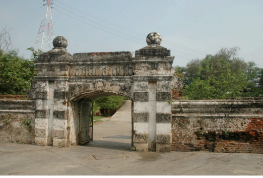
ป้อมแปลงไฟฟ้าซึ่งเป็นป้อมปืน
