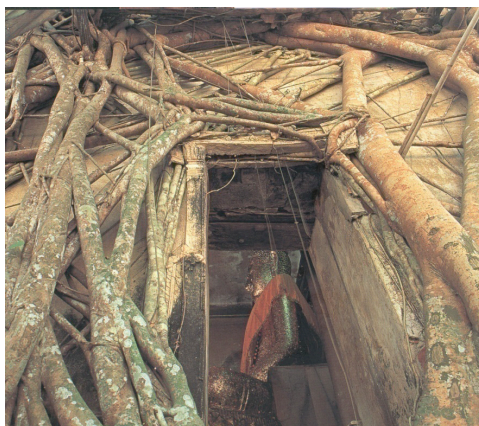
การถูกทำลายโดยต้นไม้ใหญ่ที่ขึ้นบนอาคาร โดยเฉพาะต้นไทรซึ่งเป็นไม้ใบสกุล Ficus
