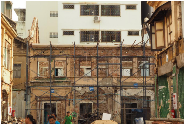
การอนุรักษ์กลุ่มอาคาร ส่วนที่ต่อเติมภายหลังถูกรื้อออกไปจนเหลือแต่ โครงสร้างดั้งเดิม ก่อนการบูรณะฟื้นฟู เครดิตภาพ: บริษัท ชุมชนเลื่อนฤทธิ์ จำกัด
