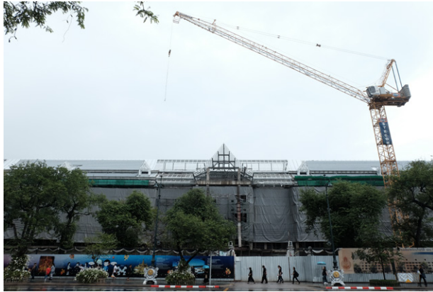
การก่อสร้างอาคารศาลฎีกาหลังใหม่
