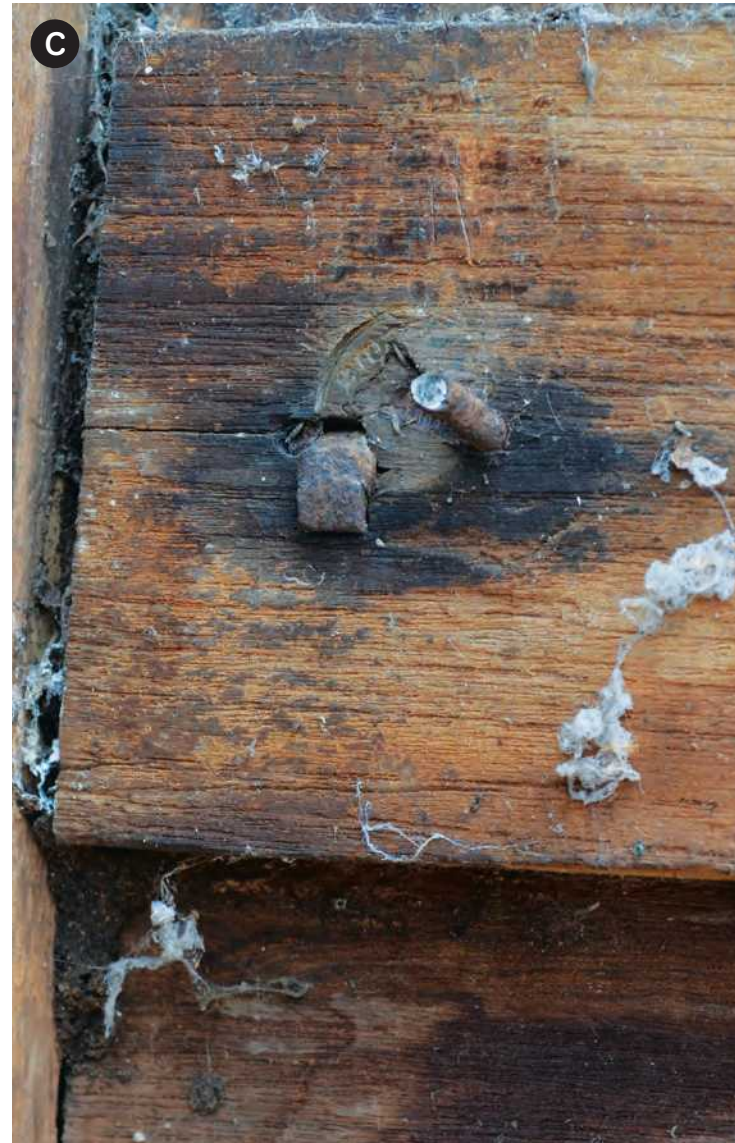
A ตะปูตอกบนเหรียญและรูเดิมของตะปูจีน B ตะปูตอกผ่านเหรียญต่างค์ C ตะปูจีนและร่องรอยกดของเหรียญต่างค์บนผิวไม้
