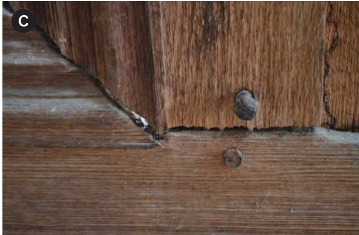
A ความเสียหายจากรา B ความเสียหายจากน้ำและยูวีในแสงธรรมชาติ C ความเสียหายจากการถอนตัวของลูกสลักไม้ (เดือย) เมื่อโครงสร้างขยับ
