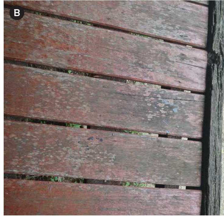
A ความเสียหายจากรา B ความเสียหายจากน้ำและยูวีในแสงธรรมชาติ C ความเสียหายจากการถอนตัวของลูกสลักไม้ (เดือย) เมื่อโครงสร้างขยับ
